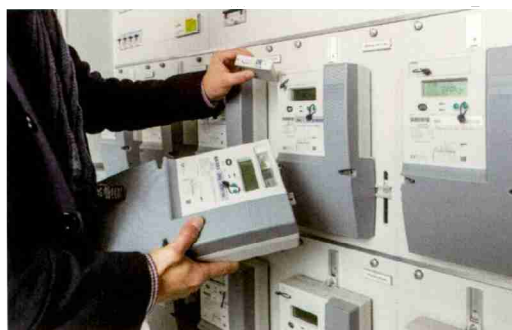
Manuelles Ablesen war gestern: Die Stromzähler von Kamstrup übermitteln die Energiedaten per Funk.
